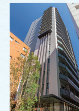
東京都港区芝大門 ■建物規模:地上17階建て ■総戸数:113戸 ■竣工年月:2021年2月竣工
