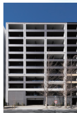
神奈川県横浜市鶴見区 ■建物規模:地上11階建て ■総戸数:118戸 ■竣工年月:2022年12月竣工
