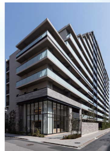
東京都江東区南砂 ■建物規模：地上13階建て ■総戸数：361戸 ■竣工年月：2023年1月
